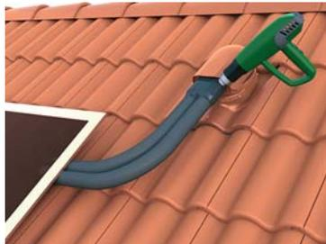
4. Разогреть уплотнитель строительным феном для герметизации выхода трубок.
