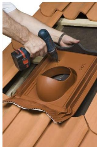
**RUS:** Закрепить верхний край проходного элемента к обрешетке двумя шурупами 38 мм в месте выступа, выбрав выступ в соответствии с расположением рейки обрешетки. Выбрать из набора уплотнитель, подходящий по профилю черепицы. Снять красную защитную пленку верхнего края проходного элемента и установить на это место выбранный уплотнитель.
