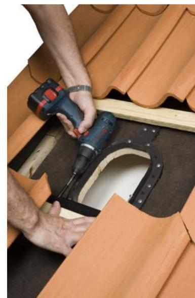
**RUS:** Планку упора закрепить к нижней рейке обрешетки двумя шурупками 80 мм строго симметрично относительно отверстия.
