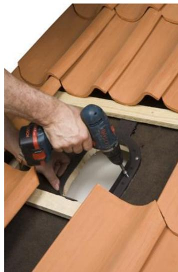
**RUS:** Прибить уплотнитель гидрозатвора гвоздями к сплошной обрешетке. При полимерной пленке и отсутствии сплошной обрешетки, завести уплотнитель под пленку, наколоть пленку на шипы и сильно прижать пленку к промазанному силиконом уплотнителю. Закрепить выступы уплотнителя шурупками к верхней и нижней планке обрешетки.
