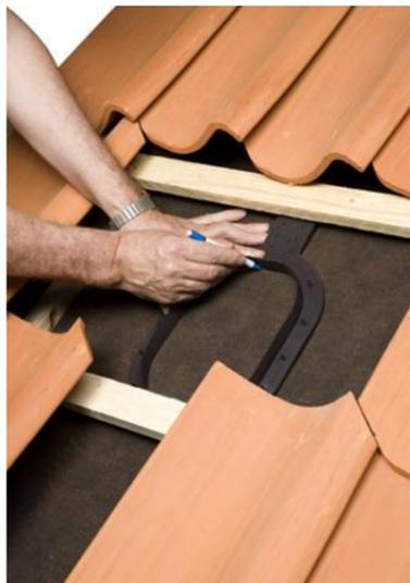
**RUS:** Очертить отверстие в подкладочном материале по внутреннему контуру уплотнителя гидрозатвора, прижав его к нижней рейке обрешетки.
