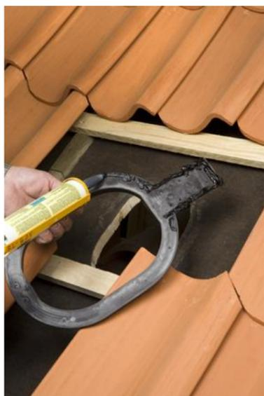
**RUS:** Если подкладочный материал- битумный, то промазать битумным клеем нижнюю поверхность уплотнителя гидрозатвора. Если подкладочный материал- полимерная пленка и отсутствует сплошная обрешетка, то промазать силиконом верхнюю сторону уплотнителя (с шипами).
