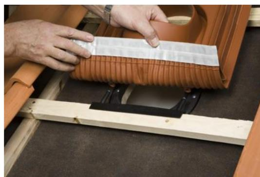
**RUS:** Снять черепицу ниже отверстия. Вставить штыри упора в отверстия проходного элемента. Если обрешетка очень частая, то в некоторых случаях приходится подстругать рейки для размещения выступа на нижней части проходного элемента между рейками.
